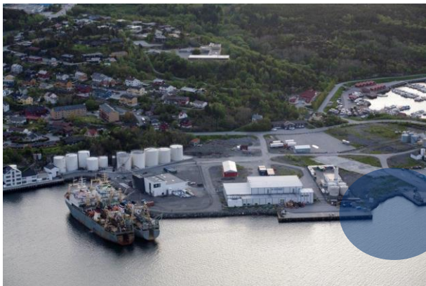
Dronefoto av Fiskeribasen. Området med mulighet for fylling i sjø til høyre. Foto: Per Kvalvik
